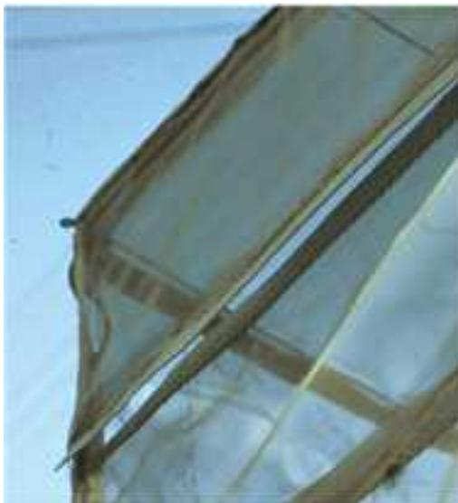
Fig. 7 - Détail d'une fente d'entrée.
